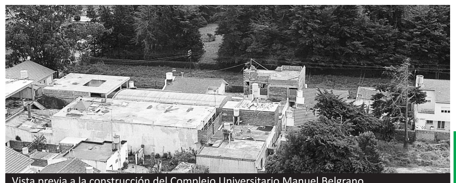
Vista previa a la construcción del Complejo Universitario Manuel Belgrano
