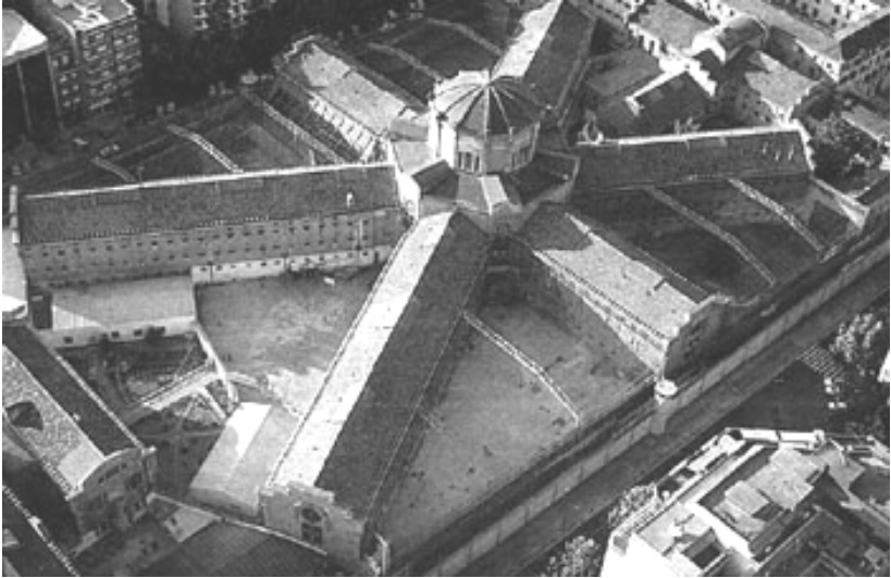
Vista aérea de la cárcel Modelo de Barcelona en la cual se aprecia la disposición radial de las galerías
