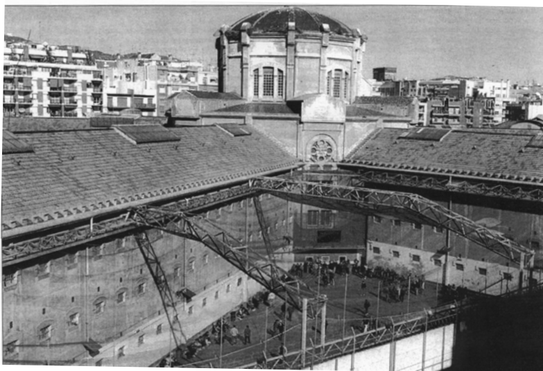
Vista desde un edificio vecino de un patio de la Modelo cubierto por la red metálica.
