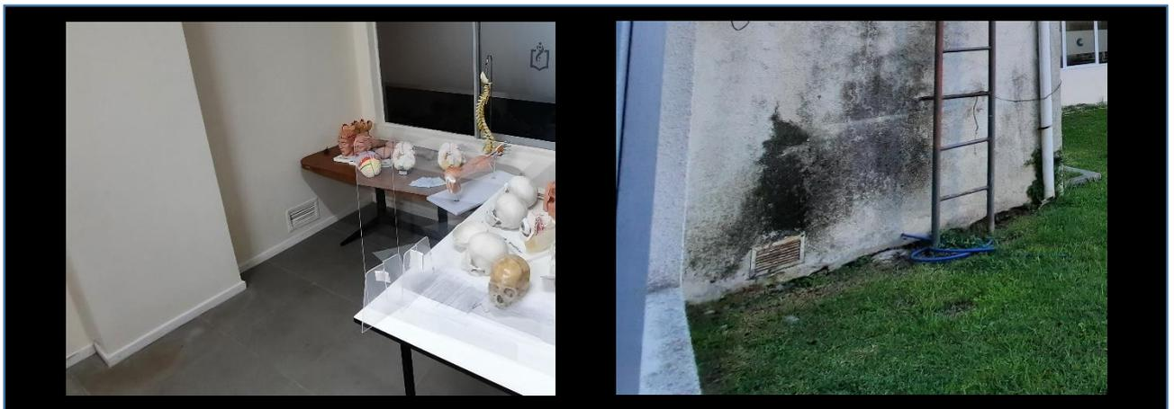
Para el caso de la rejilla existente en mismo ambiente de Calderas, que intercambia aire fresco directo del exterior, deberá realizarse limpieza del vano y cambiarlas por nuevas (interior y exterior).
