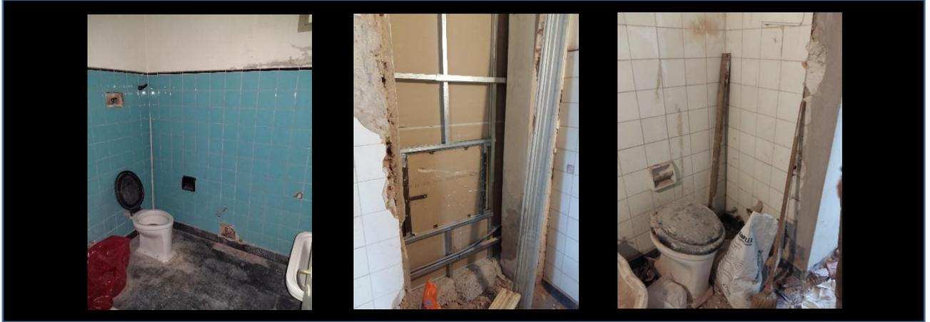
Previo a los trabajos a realizar, se deberá verificar el funcionamiento y estado de las acometidas de agua y cloacas. De encontrarse obsoletas, la OFERENTE deberá proveerlas de la manera más eficiente y directa posible para luego de completado el trabajo de la nueva readecuación de estos Baños, quede todo funcionando correctamente.
