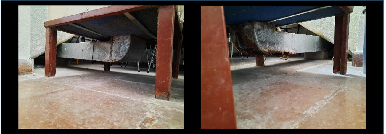
En el caso de ambas rejillas terminales de estas tomas (una al Laboratorio de Morfofisiología y la otra al Patio exterior), deberán cerrarse mediante albañilería, dejando esta reparación acorde a cada lado de la pared, dándole el correspondiente acabado y color, ya sea con pintura látex interior o exterior, según el caso.
