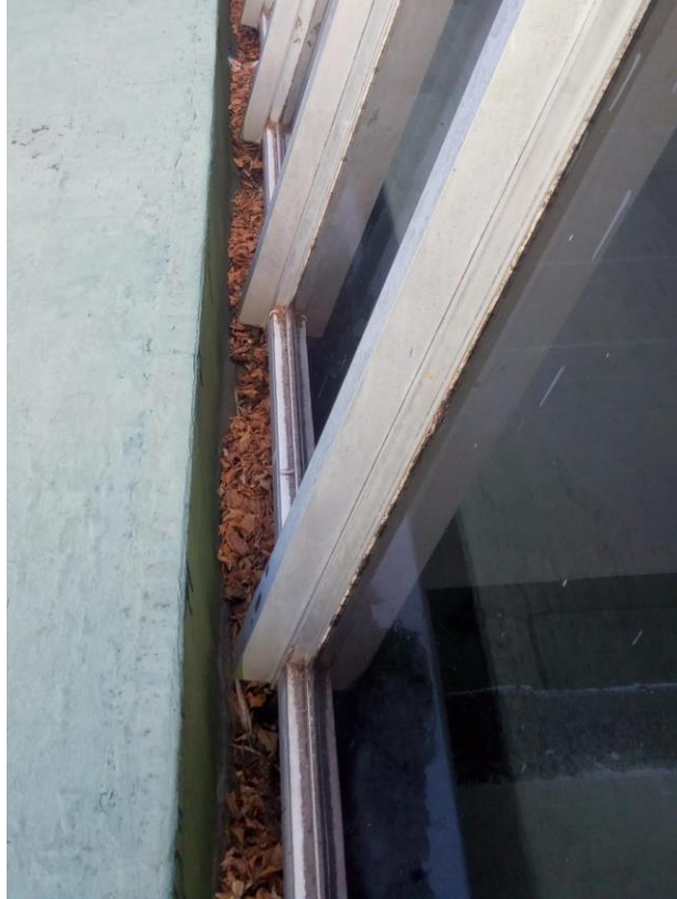
CANALETA EXISTENTE EN LUCARNA SOBRE CUMB 1
