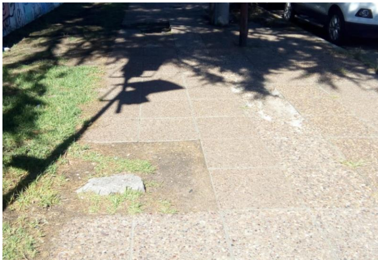
ESTADO ACTUAL VEREDA CALLE FUNES
