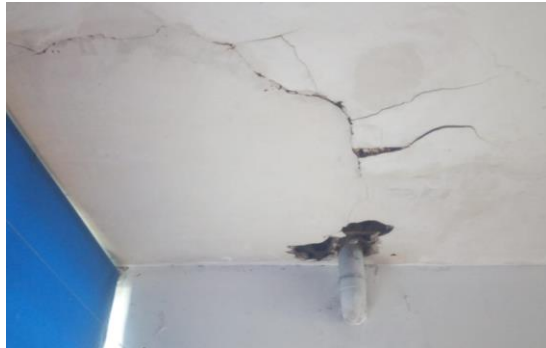
REPARACIONES DE YESO EN TALLER 5 Fac. ARQUITECTURA
