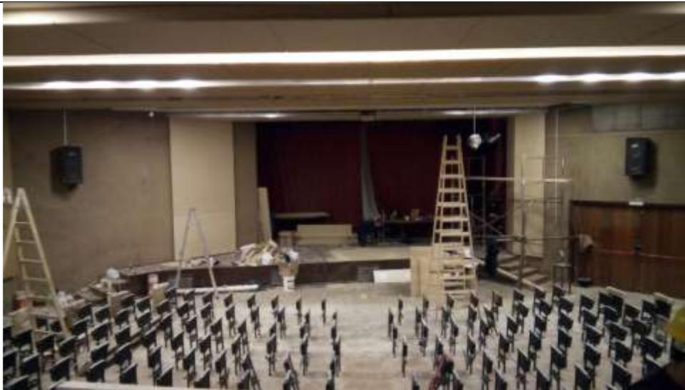
Se procederá a desarmar el sistema de audio e iluminación existente. Para esto se retirarán los parlantes originales, y las luminarias compuestas por tachos PAR de 1000 watts. Se retirarán los componentes dentro de sala de control, mixer, dimmer y tableros para reacondicionar el cableado. Incluyendo cables de señal de audio y líneas de corriente. El material que se retire se entregará al Departamento de Mantenimiento. -
