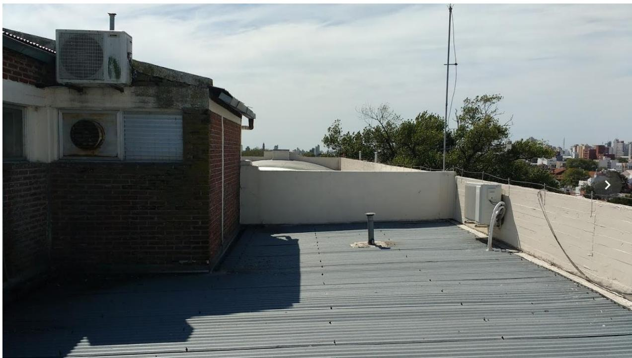
Se deberán pintar los muros de este volumen arquitectónico con látex para exteriores color ídem existente. Se dejará todo el conjunto de muros de cubierta pintado color marfil ídem existente, con dos manos de látex para exteriores tipo *Recuplast* o equivalente. Se re-ubicarán los equipos de aire acondicionado para que queden fuera del techo nuevo.
