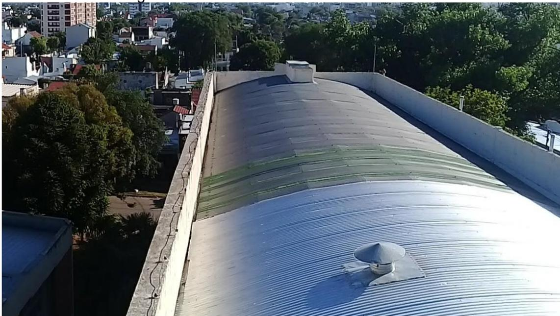
Se deberán agregar tres correas intermedia y cumbre, realizadas con perfil C Galvanizado de 100mm, soldados a cerchas parabólicas y dispuestas como indica en esquema, para dividir la luz de apoyo de la chapa junto a canaletas y en el cumbre. Largo 60mts lineales.
